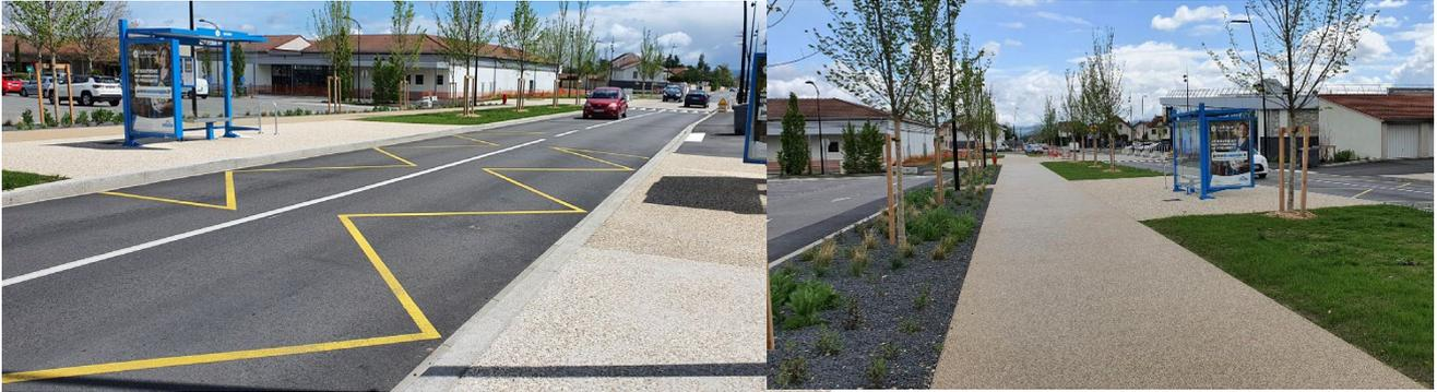
*L'Avenue de la Mairie avec la réalisation d'un plateau traversant en béton désactivé – Voie modes doux en revêtement perméable.*
